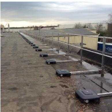
A partir de 3 mètres, la loi préconise de protéger le travail en hauteur en privilégiant le collectif avant l'individu. L'équipement de protection collective (EPC) par excellence sur les toits plats est le garde-corps. Cette barrière de protection standard ou sur mesure, en aluminium ou en acier galvanisé, permet de protéger des chutes de hauteur. On le pose de manière temporaire ou permanente en fonction du besoin.
